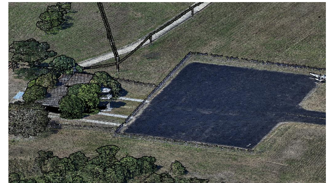
Ilustración 5 Escaneo Trimble Harrier
